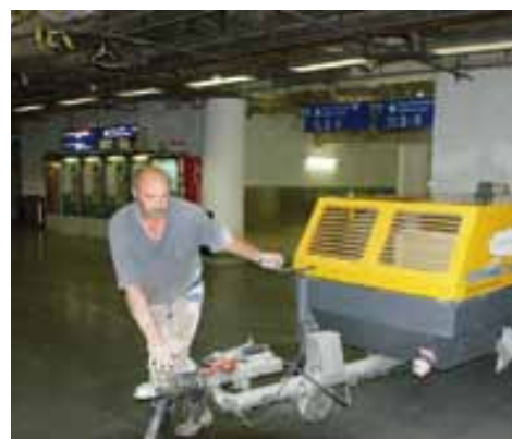
Mangels Zufahrtmöglichkeit zur Baustelle war viel Muskelkraft gefragt
